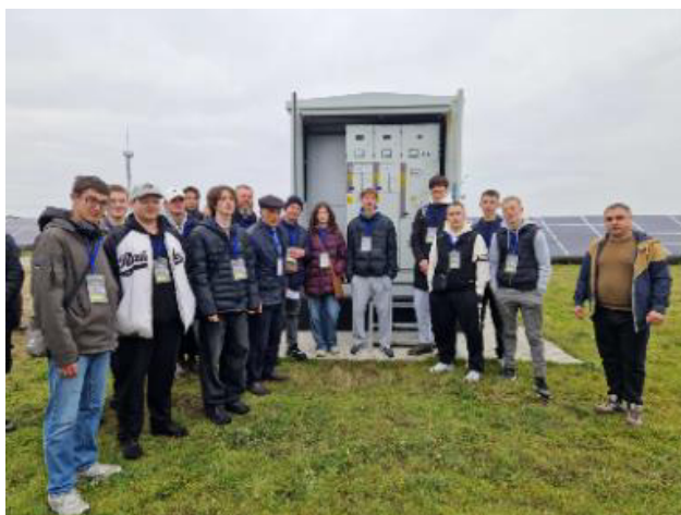
Відвідування фотоелектричної сонячної електростанції студентами агробіотехнологічного факультету в рамках проєкту COPiLOT
